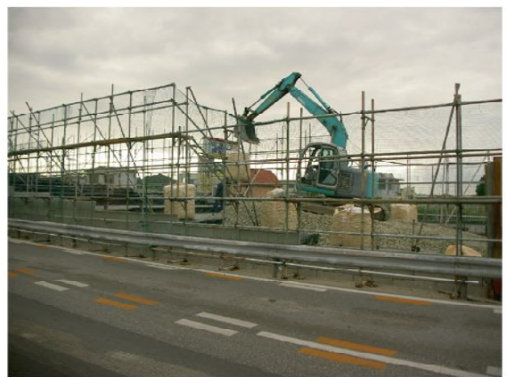
▲工事現場外観
