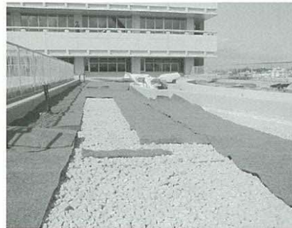
写真12 屋上緑化(施工時)
