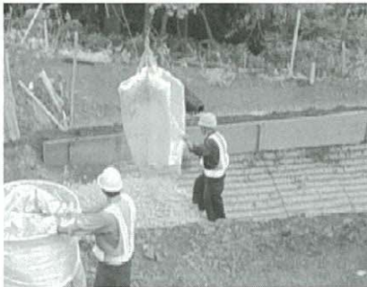
写真11 傾斜地での盛土
