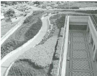
写真13 屋上緑化(完成時)
