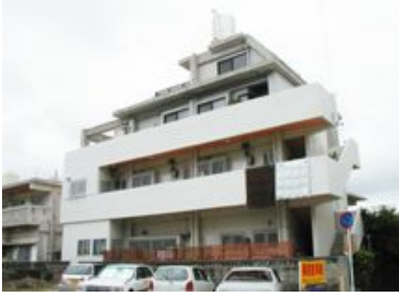
▲住宅（屋上に施工）
